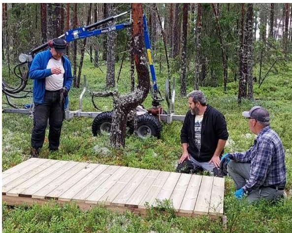
Tee läggs placeras ut
